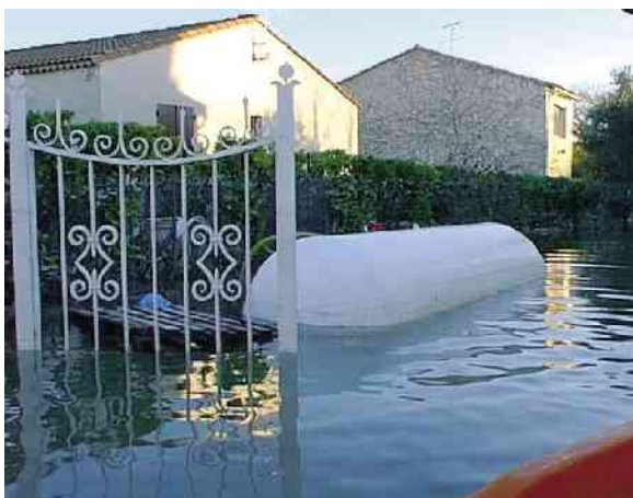
Cuve soulevée par l'eau.
